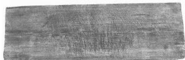
南・東面横板として転用された組板 写真上半分が南面に、下が東面にそれぞれ分割転用
