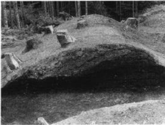
SF 102土塁盛土状況
