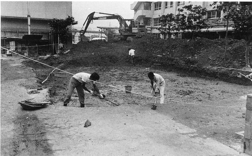
2. 作業風景（北西より）
