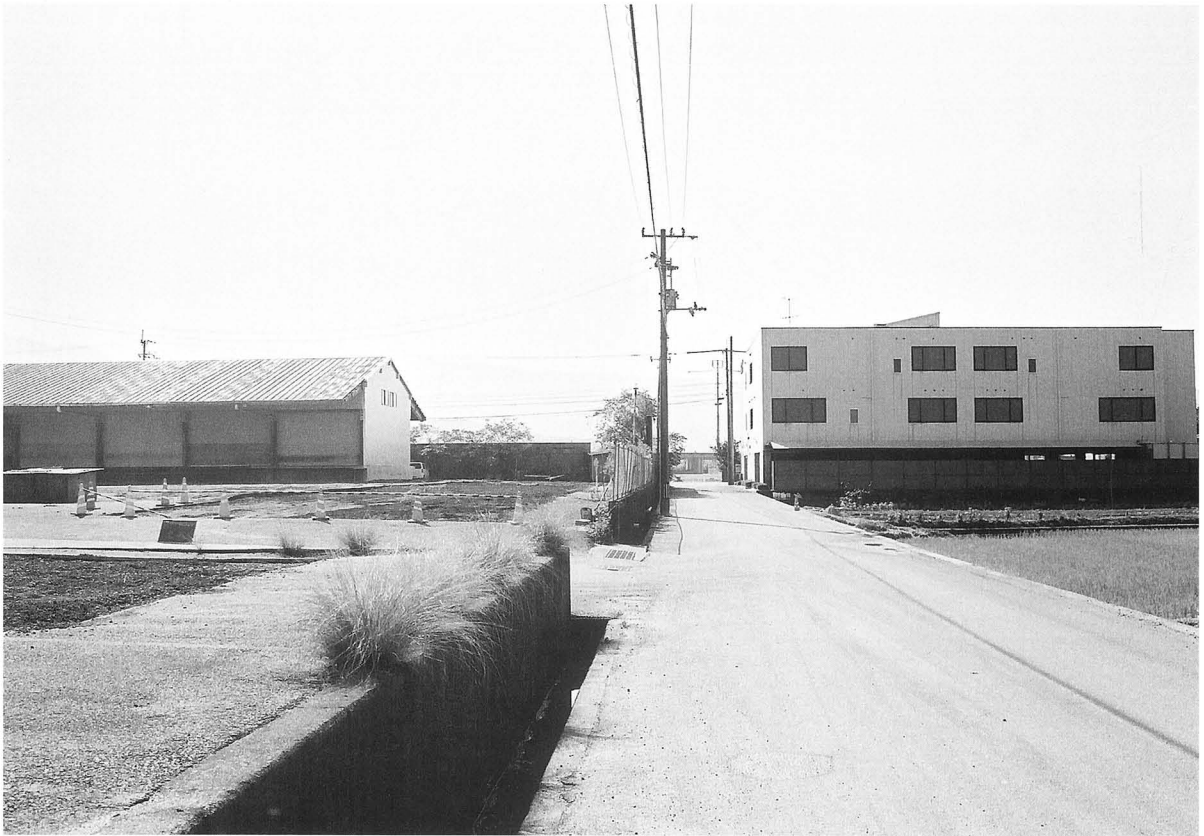
1. 調査地全景（北より）
