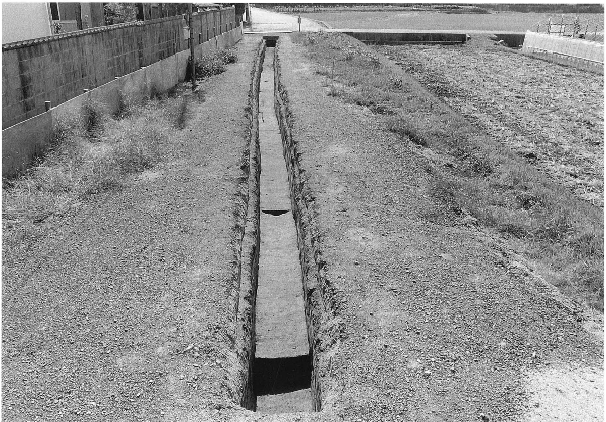
2. 6区完掘状況（北より）
