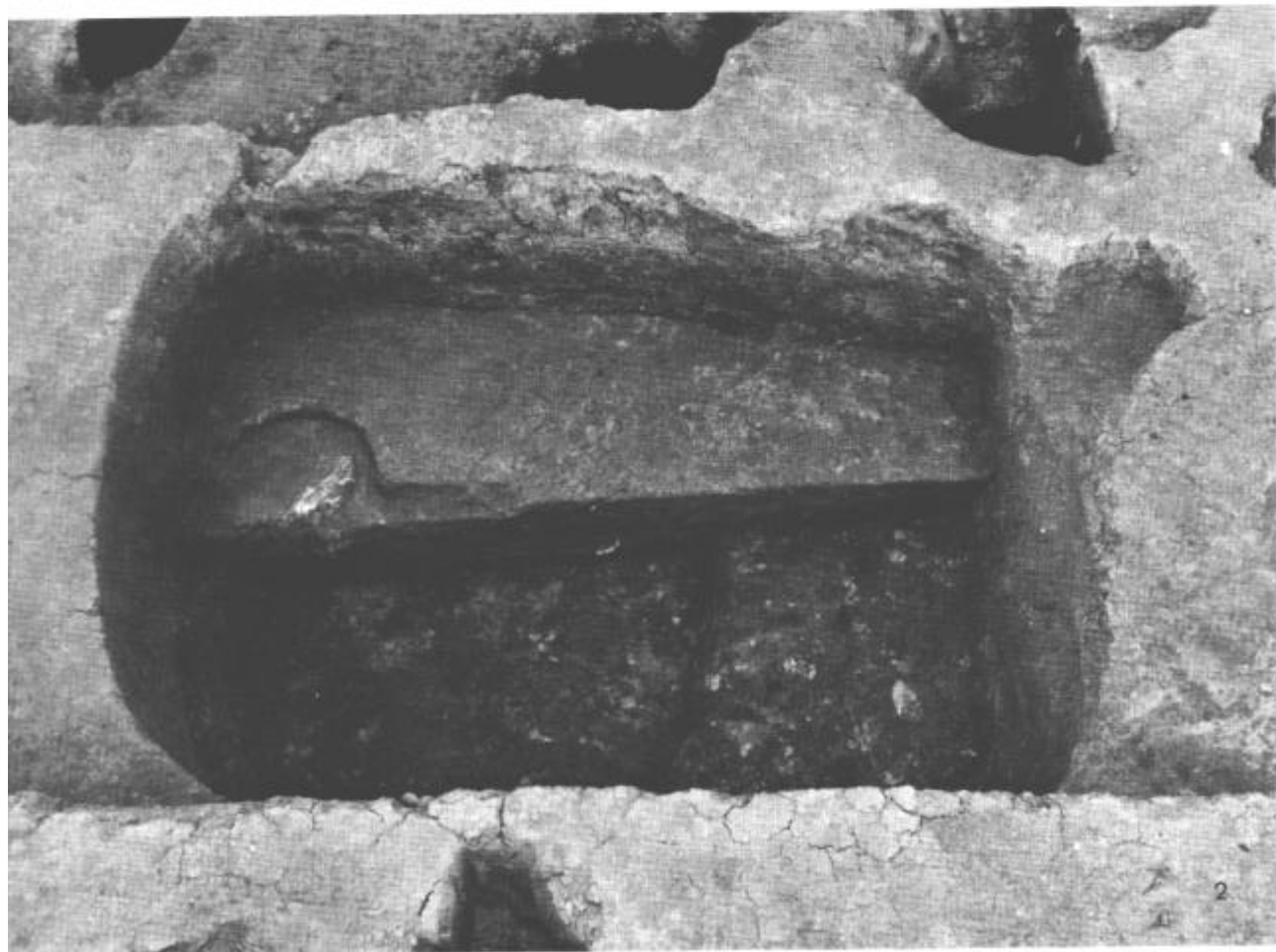
图版14 1 SB370A·B-9建物·柱 [南▶北] 2 同 土層 [南▶北]
