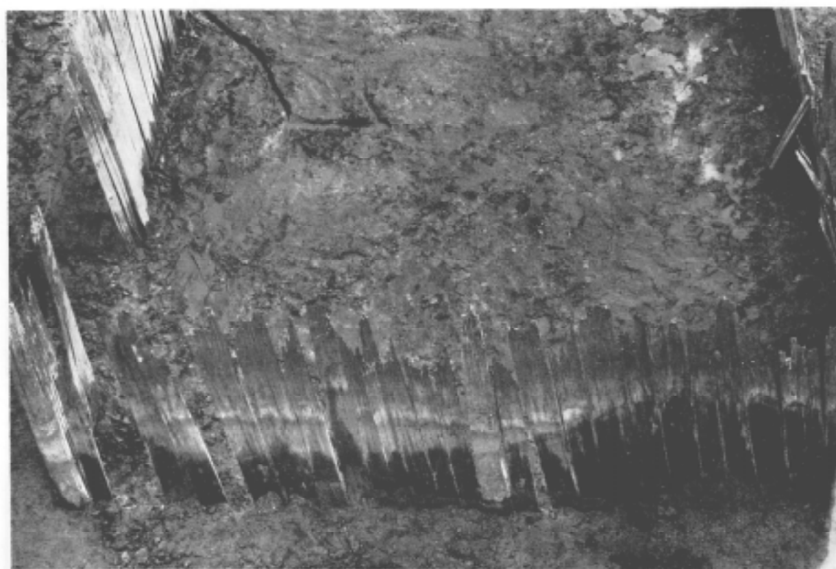
第 31 図 B 1 建 物 写 真 (1) 北から北東隅をのぞむ。近景の壁板列は、この建物の 北側の一辺である。
