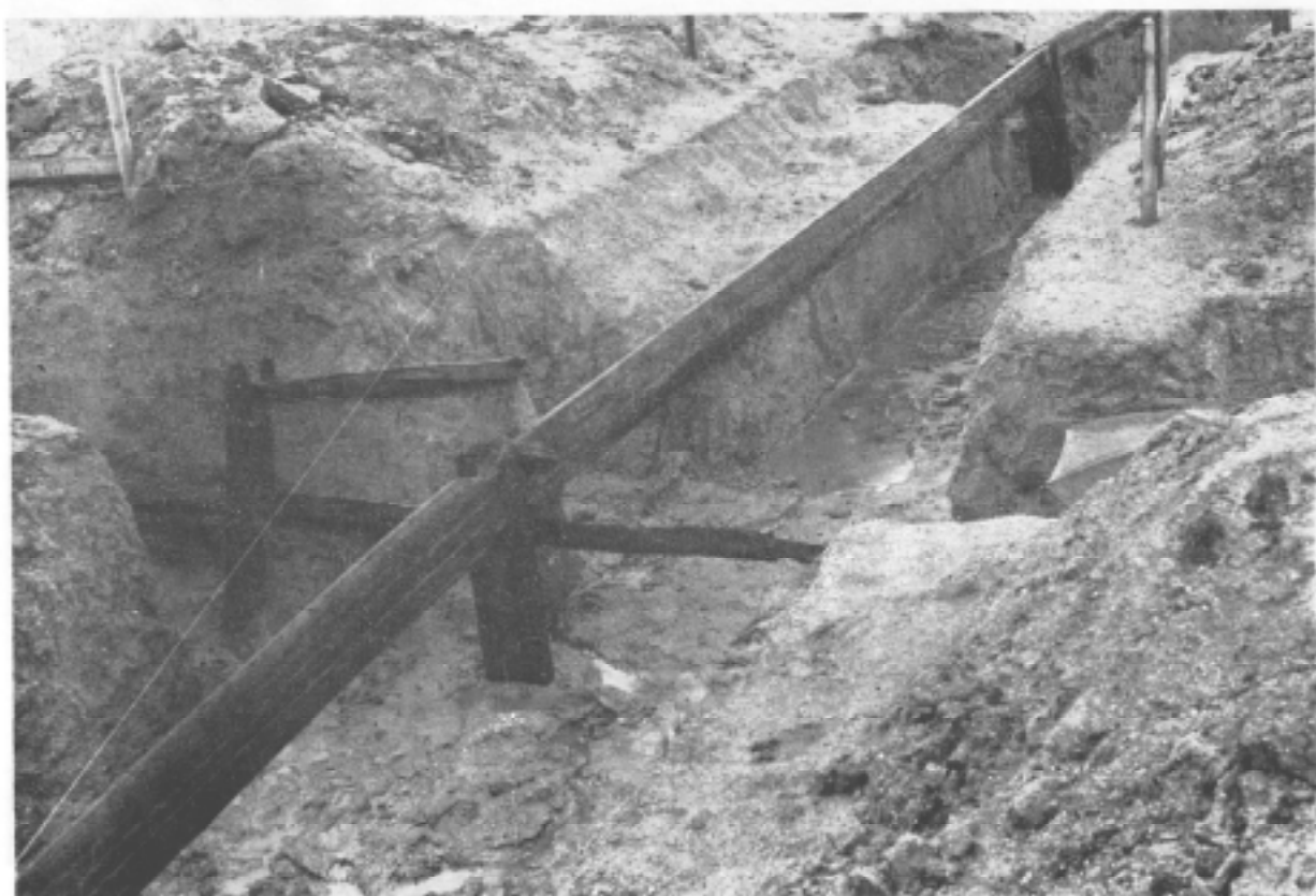
第21図 A2 柵列写真(4) A2柵列から分岐してA3柵列が南方(向って左手)に延びて 行く結合場所を東北からみたものである。
