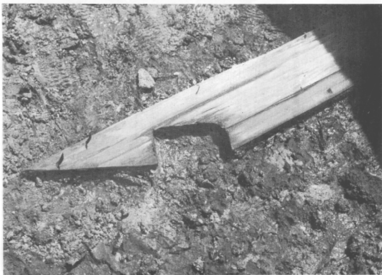
第43図 B2建物内、床根太下削い物、 他材の断片が利用されている。
