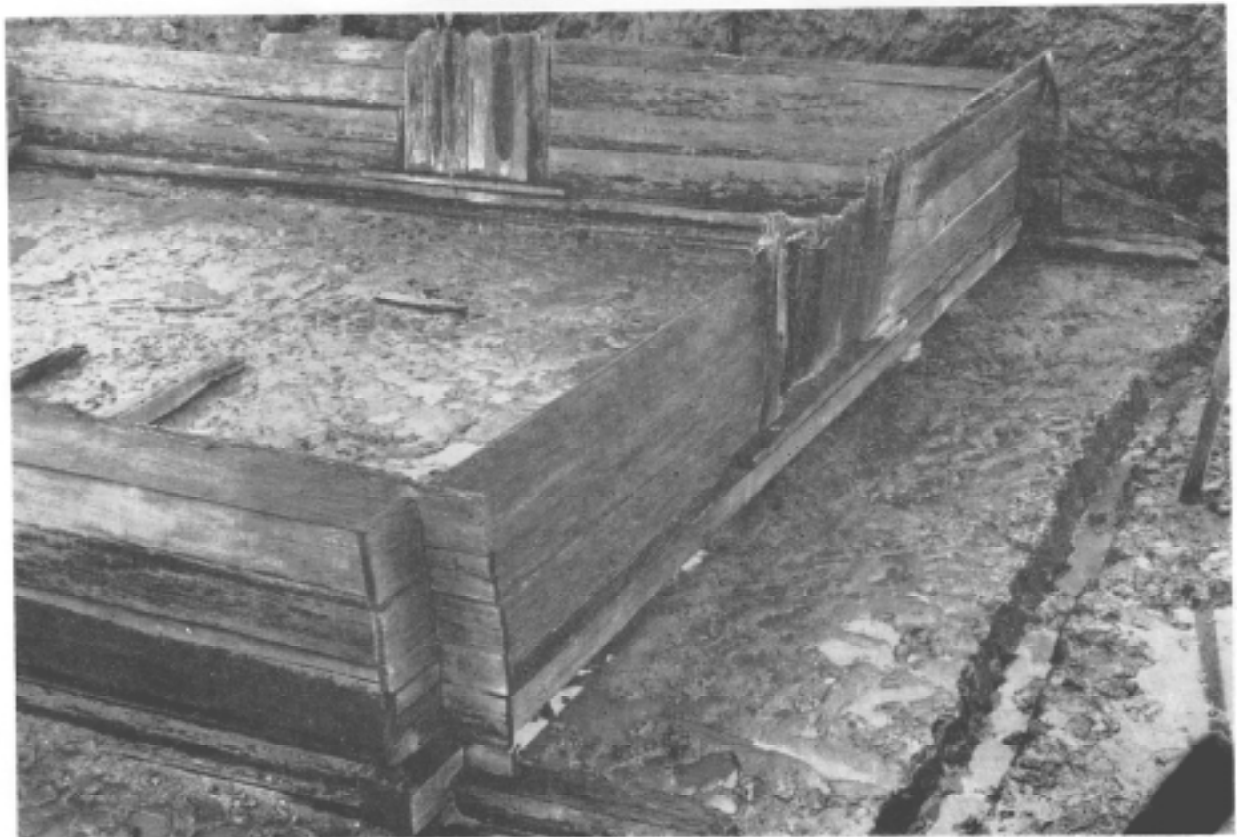
第 47 図 B 2 壁板隅部分組合せ工法写真 (2) 西南隅を西からみたものである。したがって右手 (南) に 南戸口、南戸口のさらに右手 (南) に棟持柱の一部もみえて いる。
