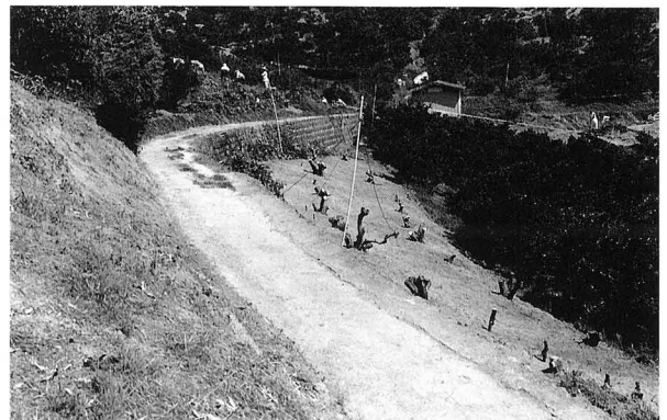
3. 調査地南部伐採状況（南より）
