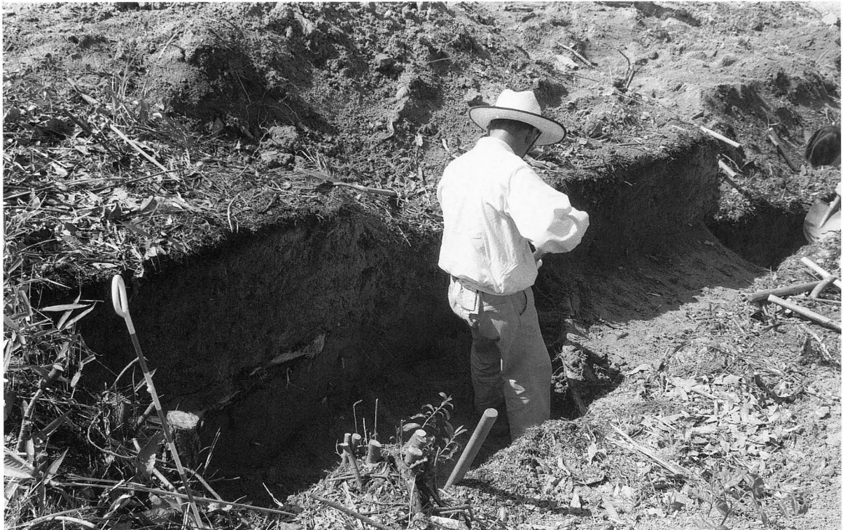
1. 2区T3作業状況(東より)
