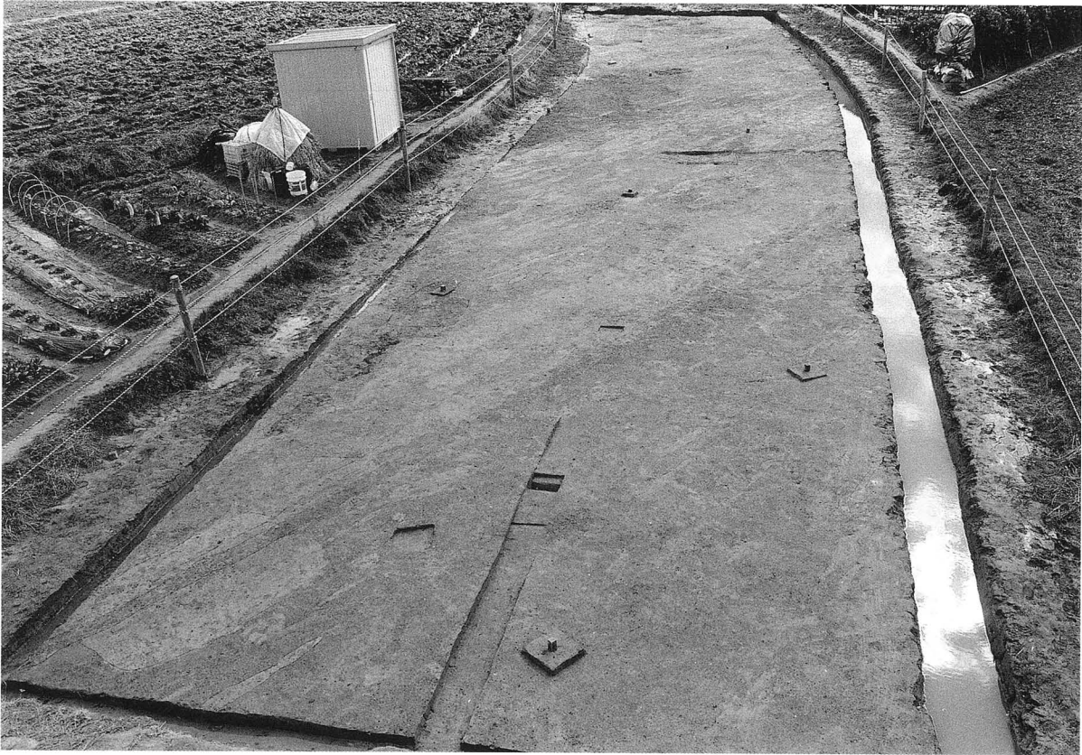
1. 1A区遺構検出状況（第Ⅱ②層上面）（北西より）
