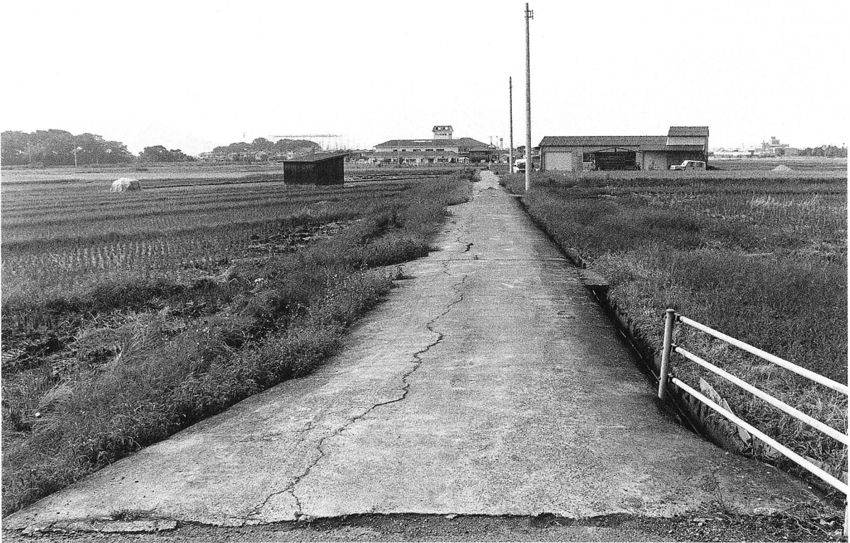
1. 調査前全景(1) (東より)
