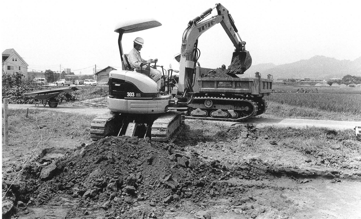
1. 掘削状況（南より）
