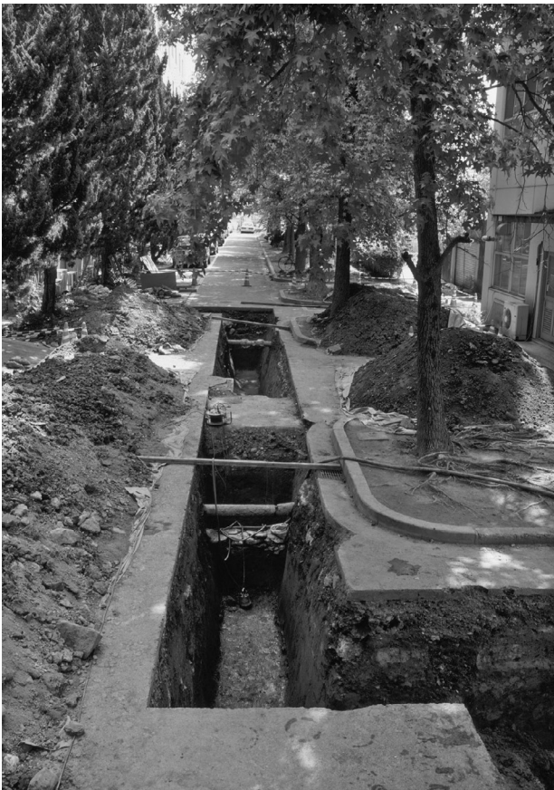
2 7次調査ⅣD～ⅣF区全景（西から）
