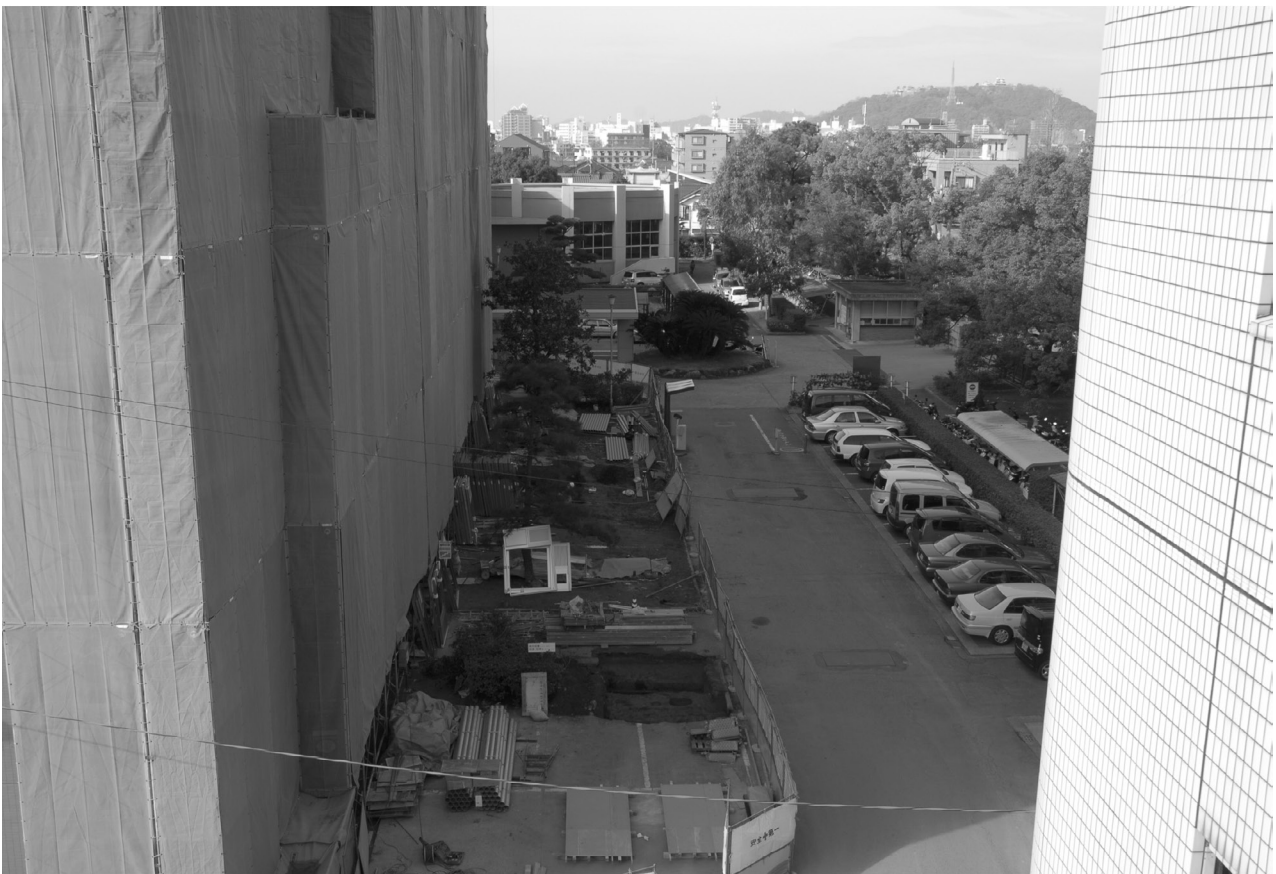
2 8次調査3・4区遠景（東から）
