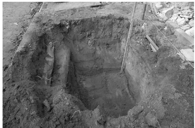
4 8次調査2区完掘状況（東から）
