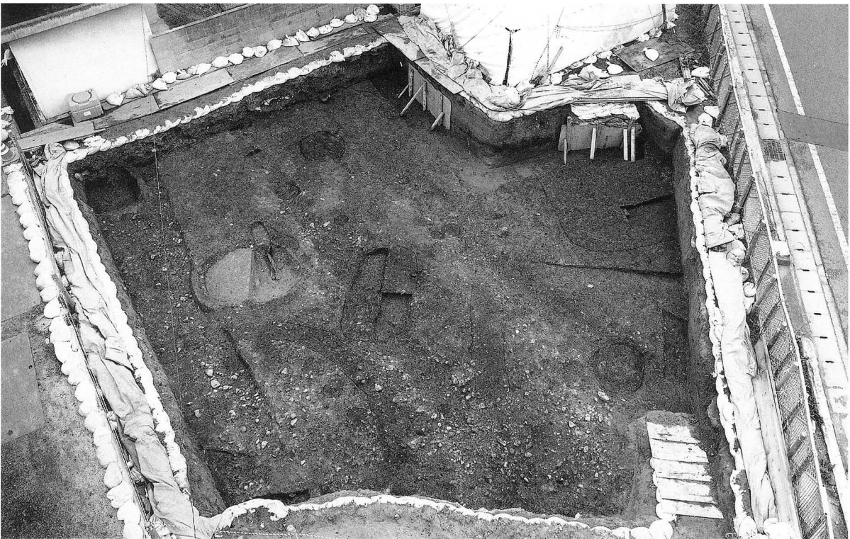
2. II区遺構検出状況（北西より）
