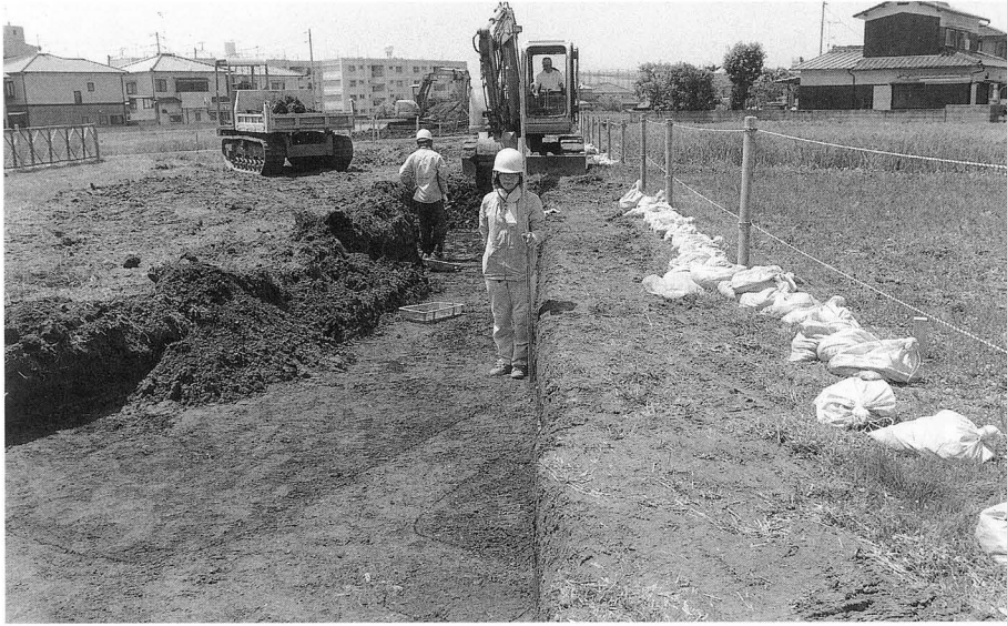
1. II区表土除去状況 (北東より)
