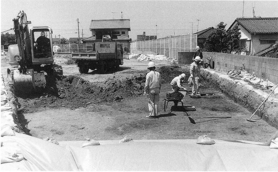
1. II区表土除去状況 (東より)
