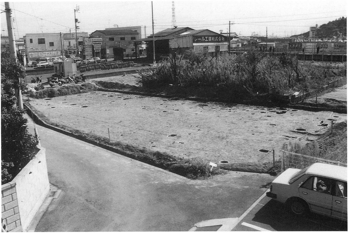
調査地全景（北西より）
