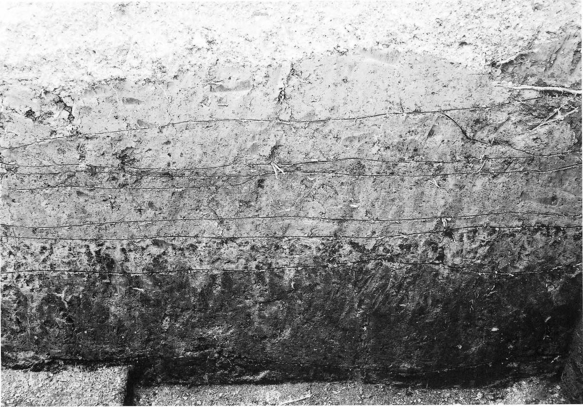
1. 南壁土層（北より）
