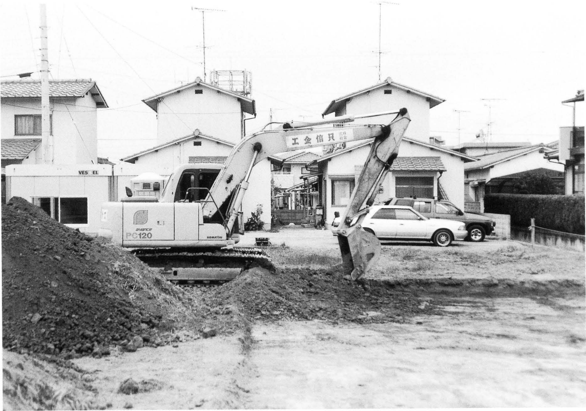
1. 掘削状況（東より）
