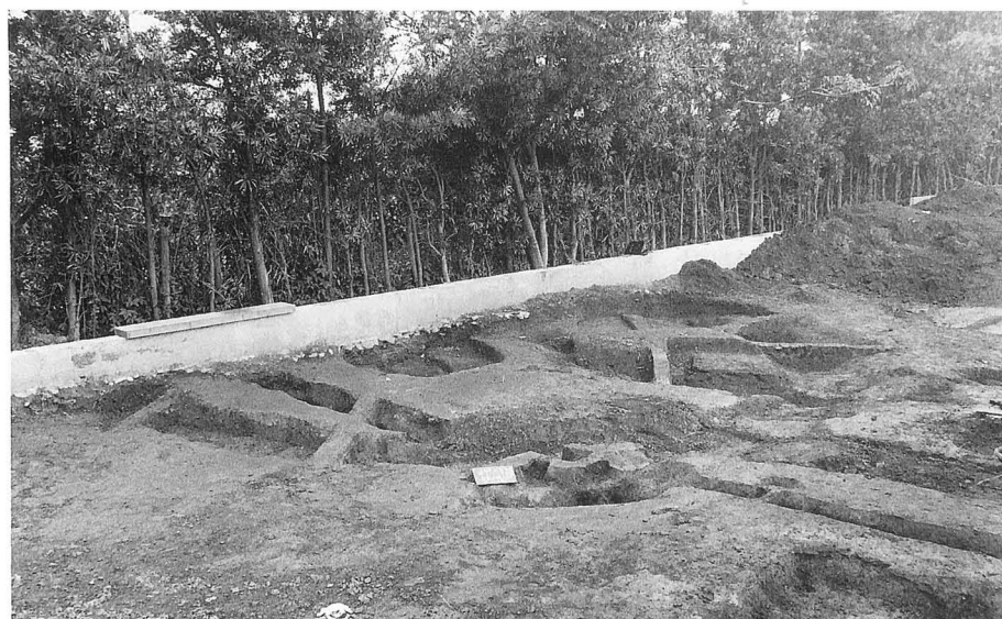
写真23 15号墳完掘状況 (北より)
