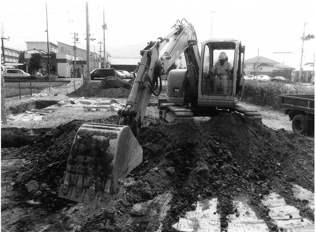
2. 掘削状況（西より）
