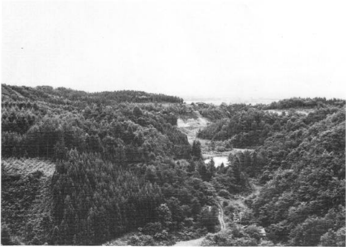
高瀬館（熊館部分）遠景
