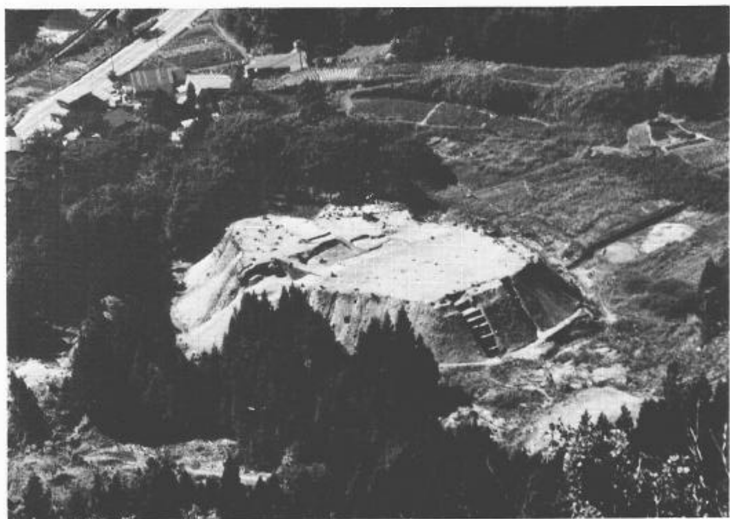
図版43 館口全景 (上) 調査前 (下) 調査終了時
