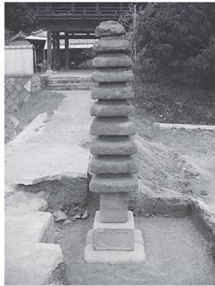
十三重塔 全景（積み直し後）南から
