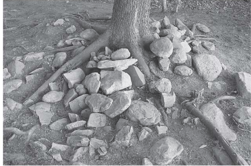
第1テラス S10 腐葉土・腐植土除去状況 東から
