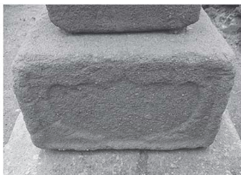
基礎(格狭間) 北から
