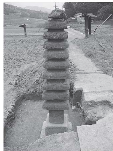
十三重塔 全景（積み直し後）北から
