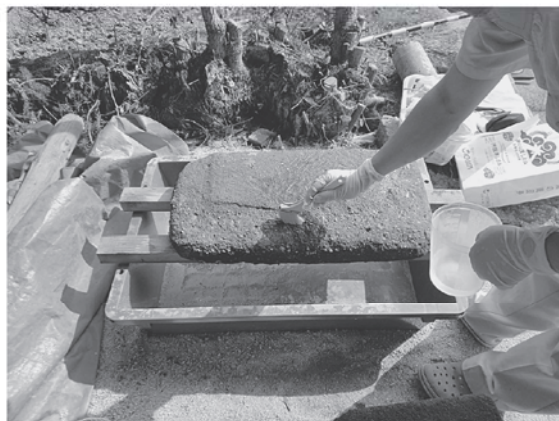
防腐剤の塗布
