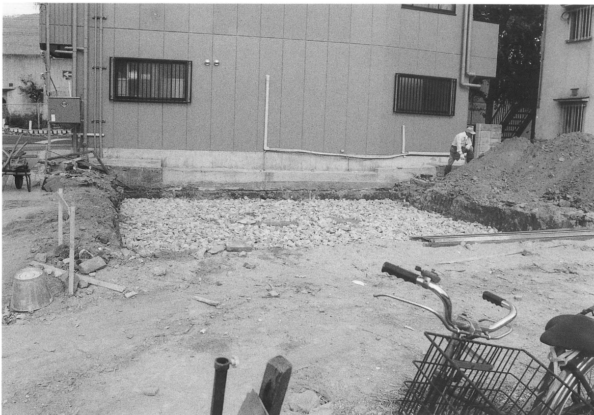
調査前全景（南から）
