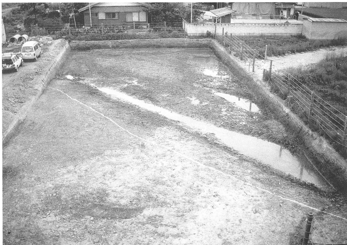
1. SR03完掘状況（東から）
