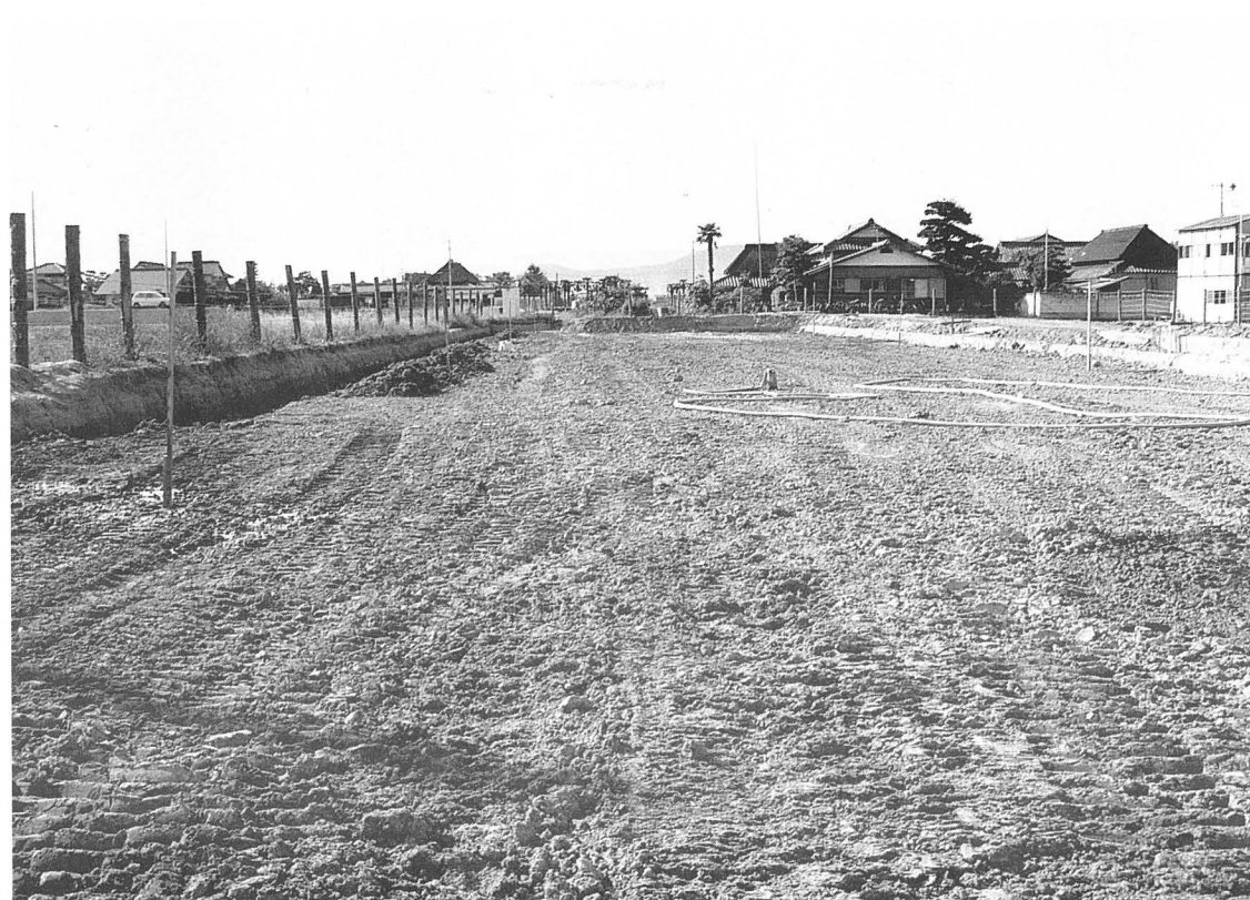
2. 調査終了状況（東から）
