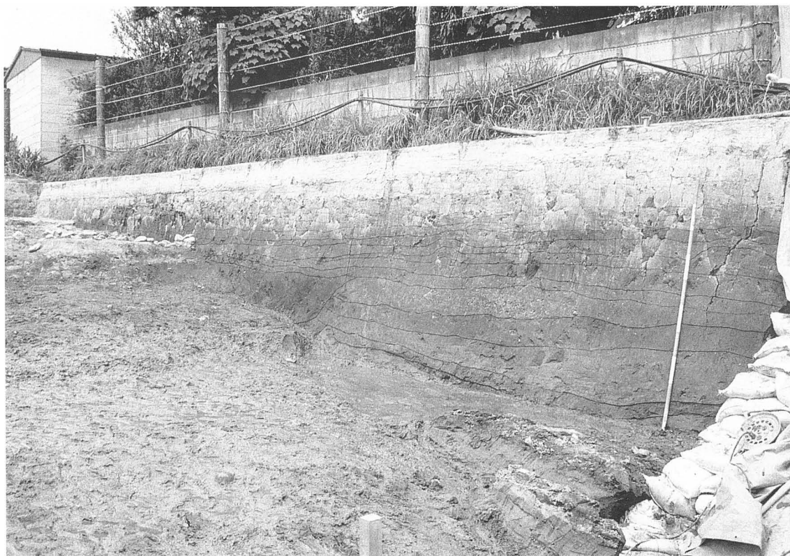
1. SR04北壁土層堆積状況
