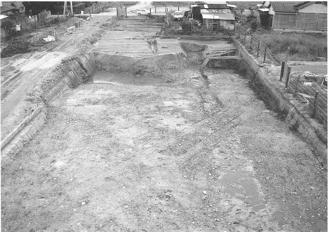
2. SR04南部完掘状況（西から）
