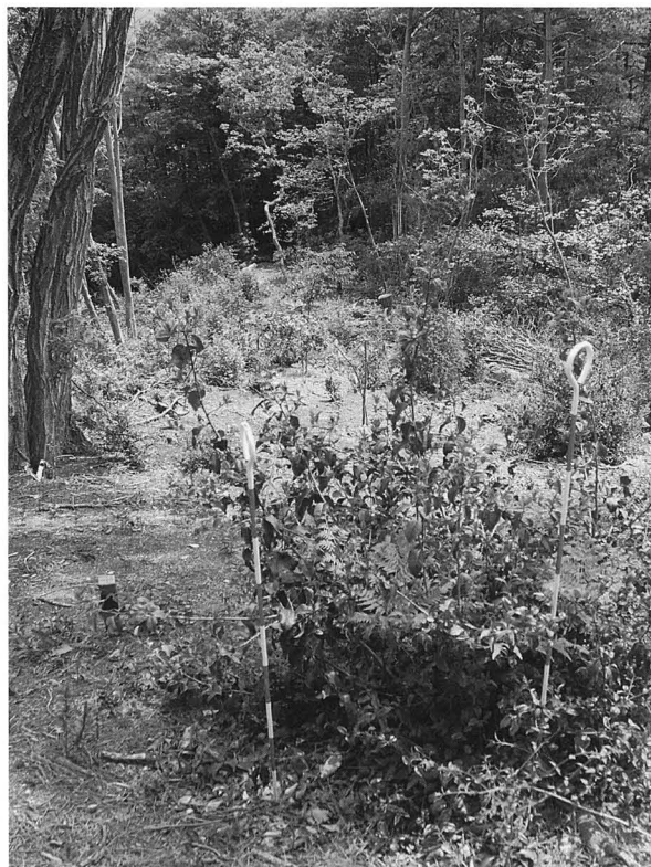
遊歩道（きた坂）階段敷設箇所 掘削前状況 西から
