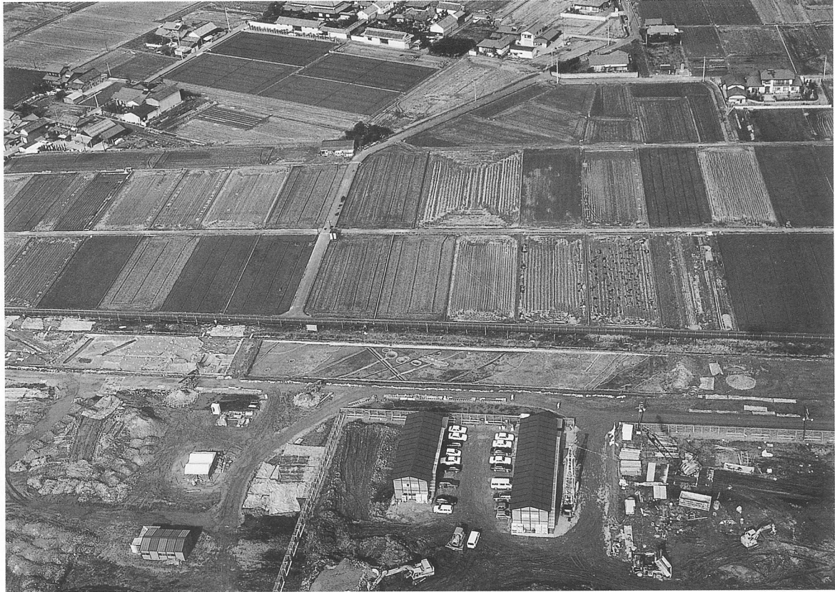
北地区全景（南上空から）
