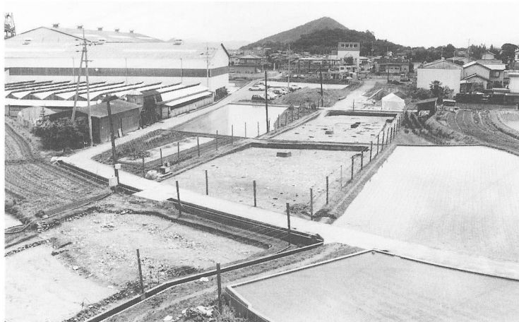
写真1 遺跡全景(西から)
