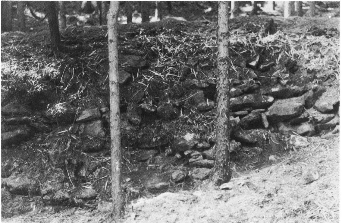
第1調査区石垣（東より）
