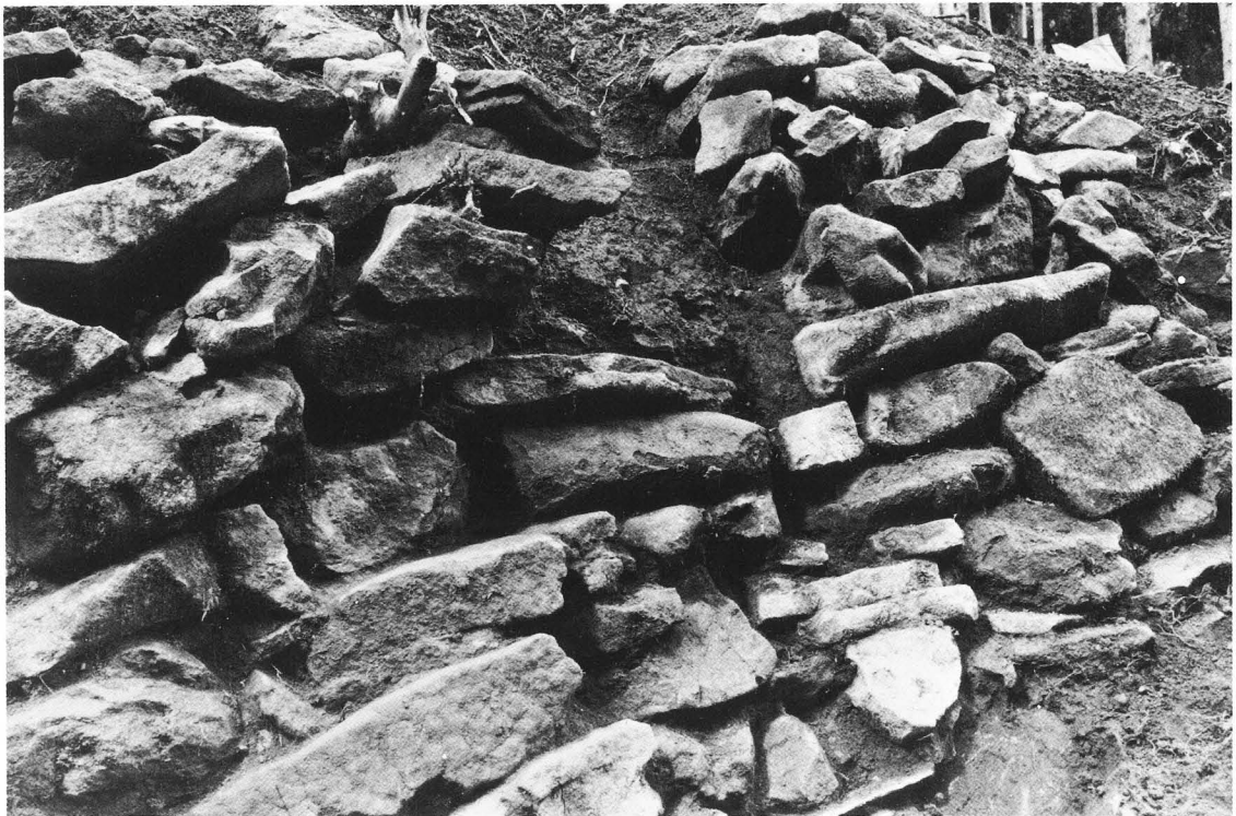
第2調査区石垣（東より）
