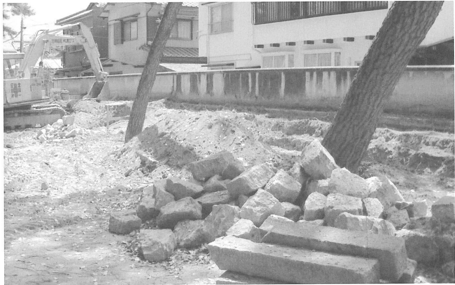
2. トレンチ周辺 (北半・北から)
