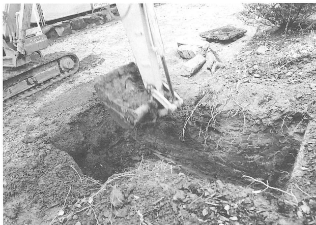
3. 重機掘削状況
