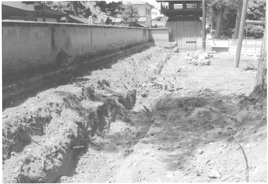
1. トレンチ周辺 (北半・南から)
