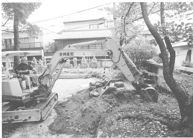
3. 重機掘削状況
