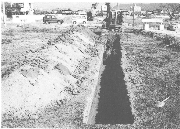
写真31 作業風景（1トレンチ）
