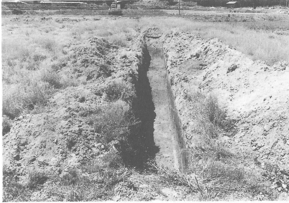
写真36 2 トレンチ全景
