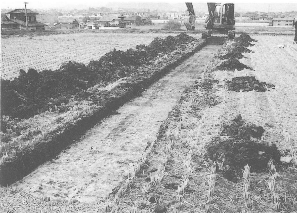
写真45 1 トレンチ掘削状況
