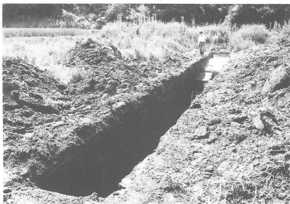
写真27 19トレンチ掘削状況
