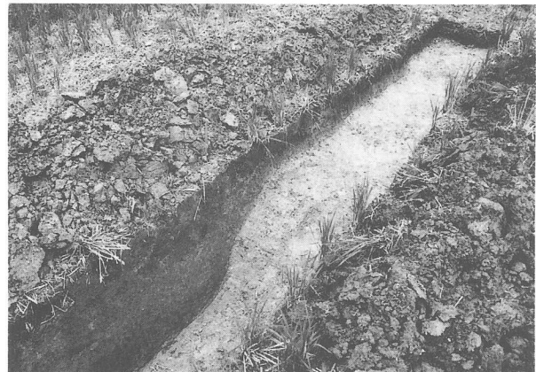
写真50 1トレンチ掘削状況
