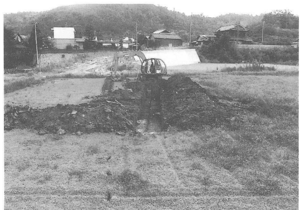
写真28 24トレンチ掘削状況
