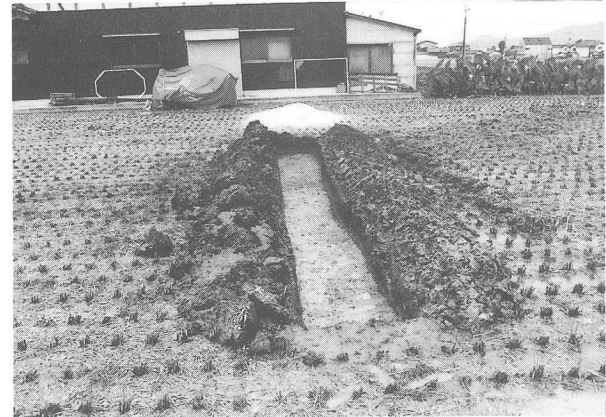
写真22 5 トレンチ掘削状況
