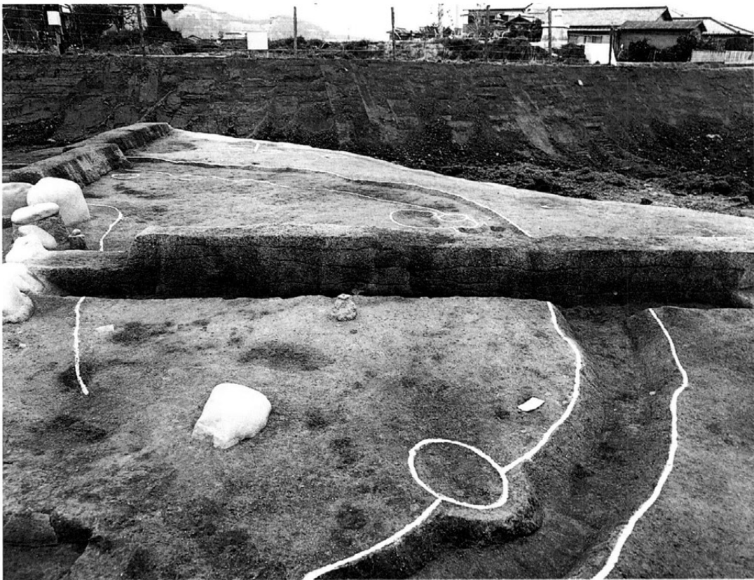
V区第1面2号墳墳丘土層断面(南から)
