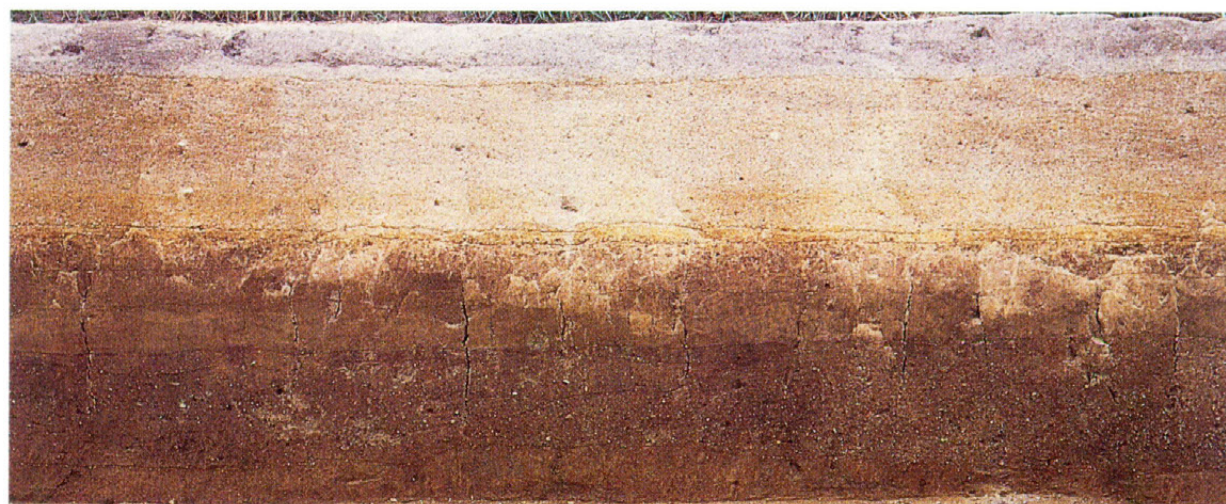
2. II-2区北壁断面(南から)
