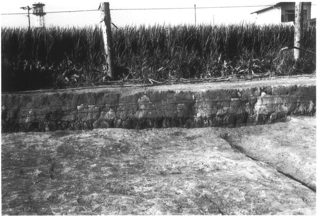
写真16 B地区南壁土層断面（北より）
