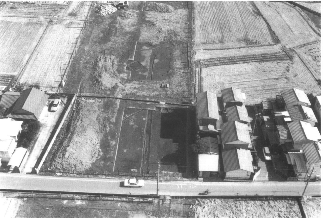
写真34 F・G地区南半部全景（西より）
