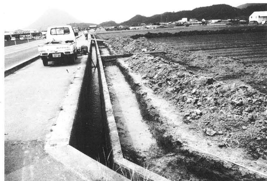
図版10 1区第1・2トレンチ完掘
