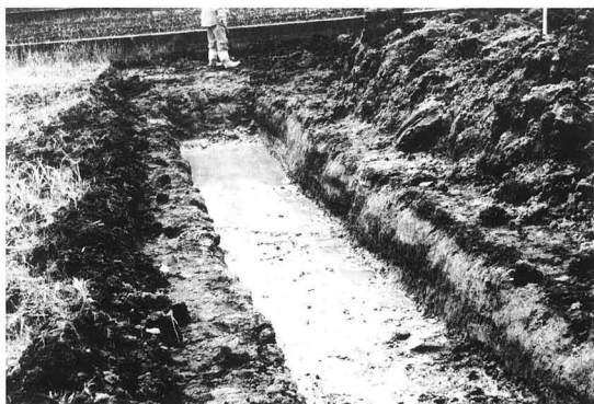
図版11 2区第2トレンチ完掘
