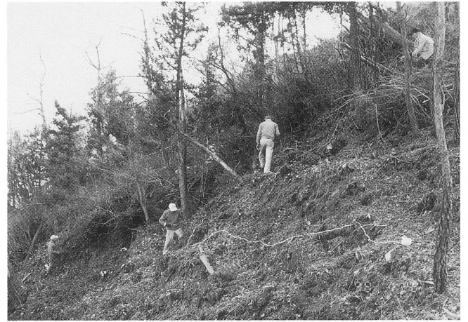
図版14 伐開作業風景
