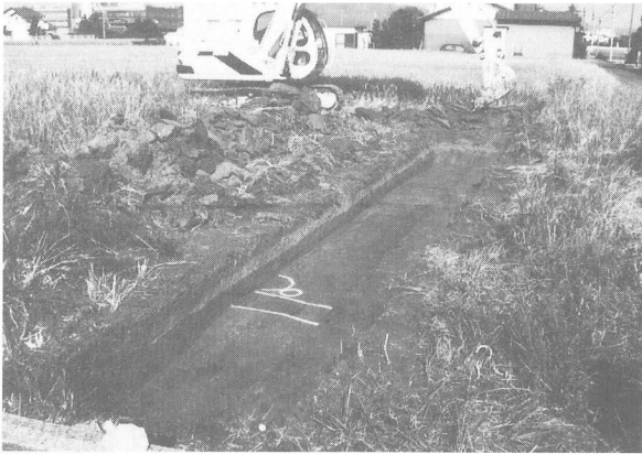
写真28 4トレンチ全景
