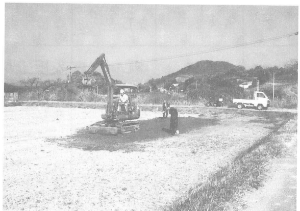
写真20 9トレンチ (埋戻し状況)
