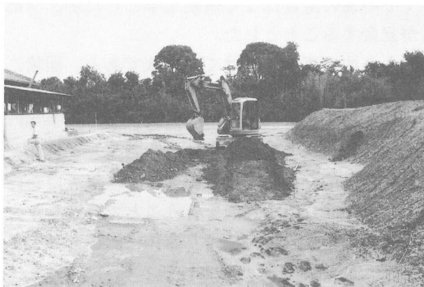
写真60 1トレンチ全景
