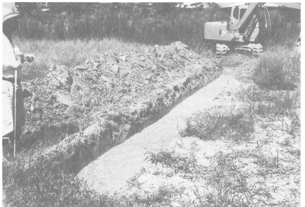
写真45 3トレンチ全景
