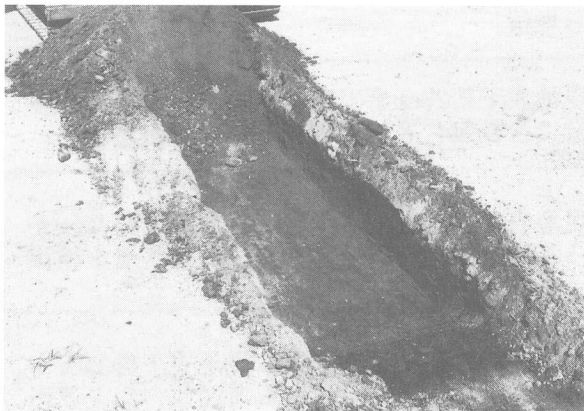
写真41 5トレンチ全景
