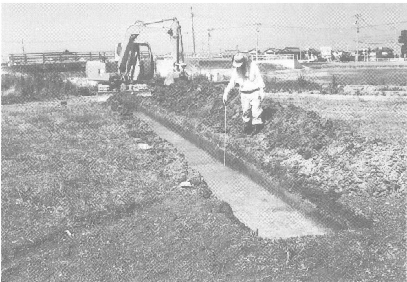
写真44 2トレンチ全景
