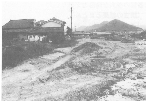
写真57 5トレンチ全景
