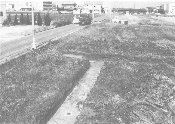
写真30 5トレンチ全景
