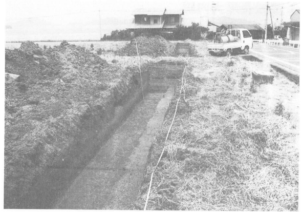
写真18 6・7トレンチ全景
