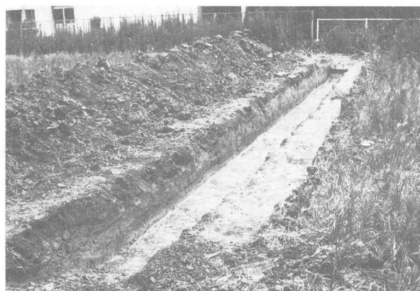
写真36 2トレンチ全景
