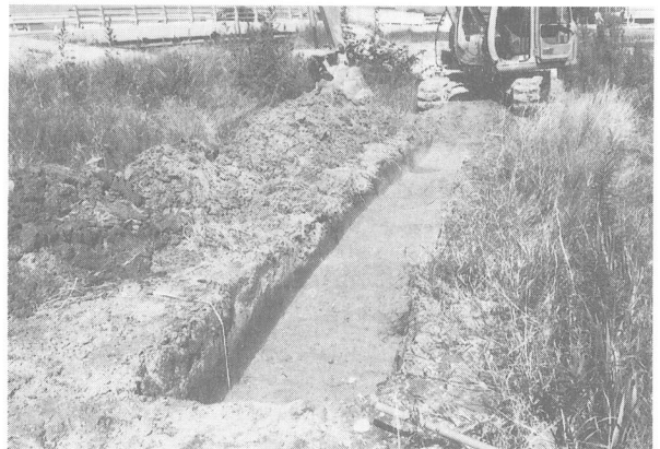
写真43 1トレンチ全景
