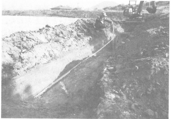
写真19 8トレンチ全景
