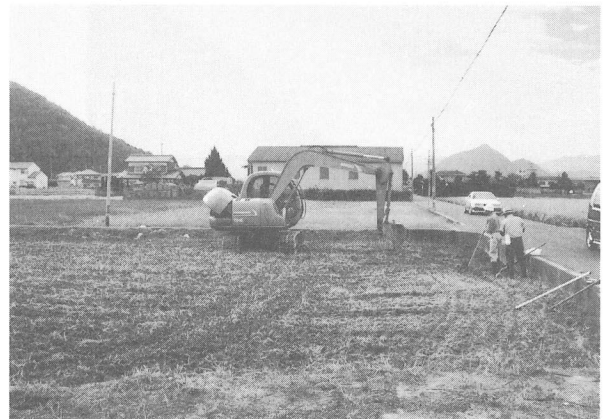
写真25 調査前風景（8～10トレンチ）
