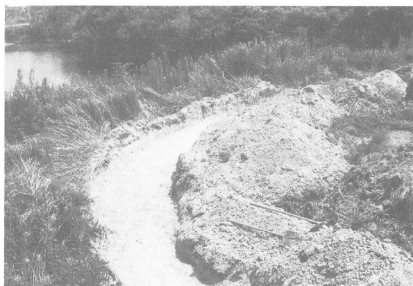
写真58 7トレンチ全景
