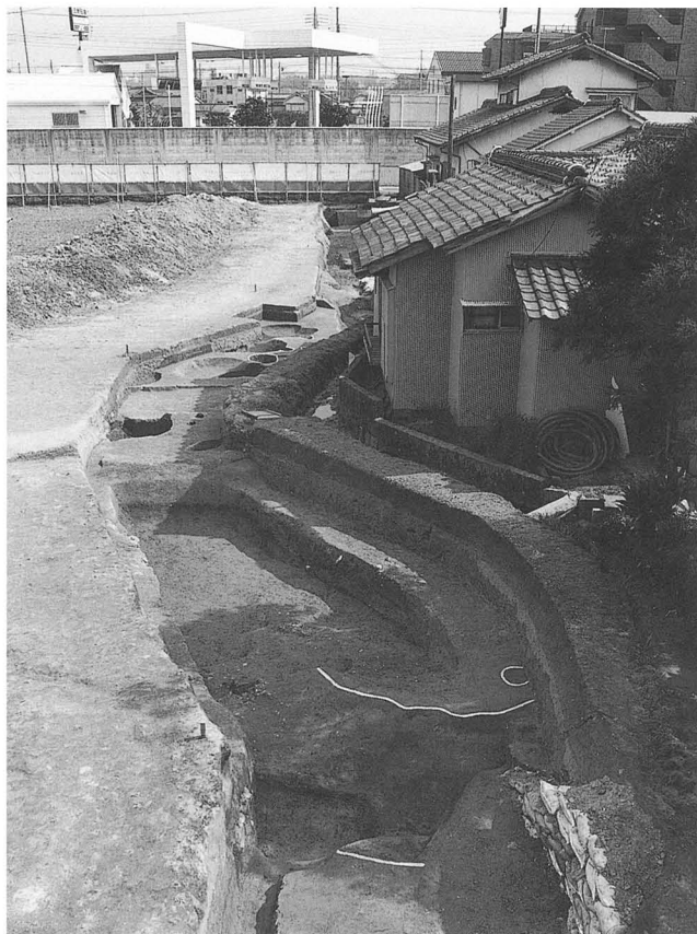
3. 第1トレンチ 第2遺構面 (西から)
