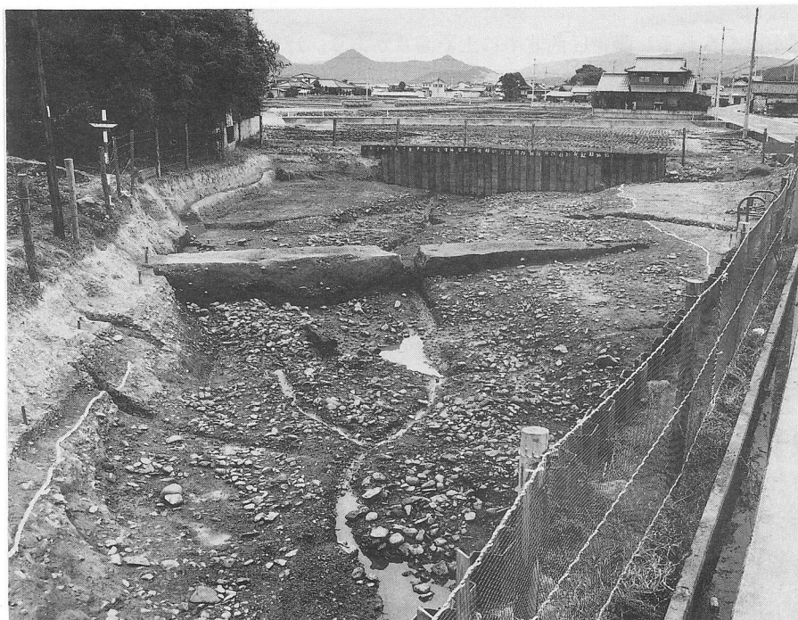
写真15 SR02 掘削状況
