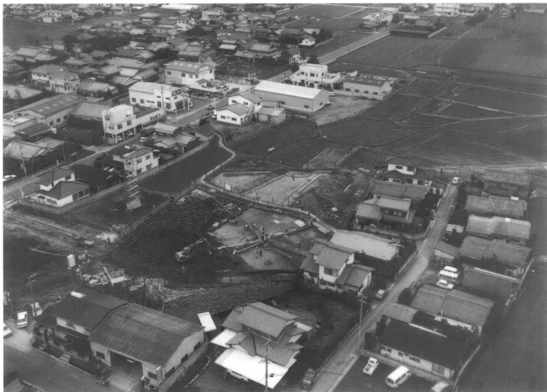
調査地遠景 (西より)
