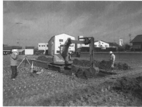
重機による掘削作業風景
