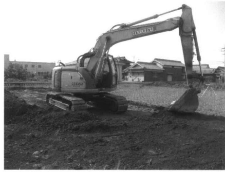
埋め戻し作業風景
