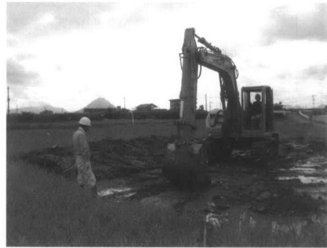
重機による掘削作業風景
