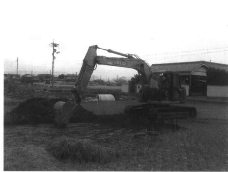
重機による掘削作業風景
