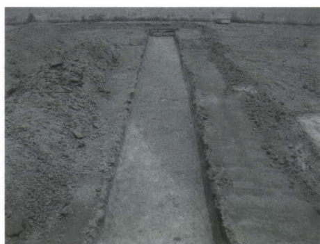
7トレンチ SD01 検出状況
