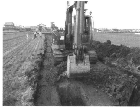
重機による掘削作業風景
