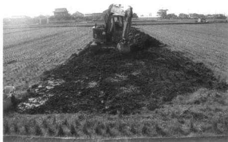
トレンチ埋め戻し作業風景
