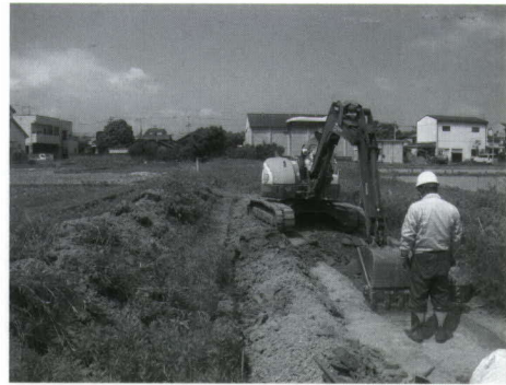
重機による掘削作業風景
