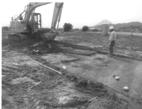
重機掘削作業風景
