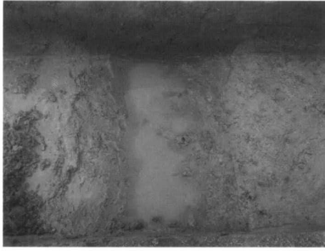
3トレンチ SD02 確認状況:南から
