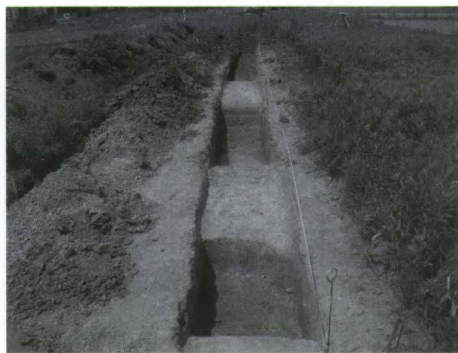
1 トレンチの溝が連続する状況
