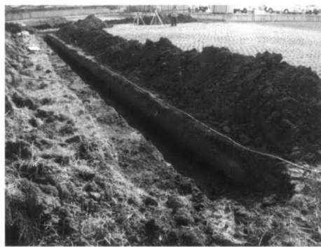
4トレンチ全景：北東から
