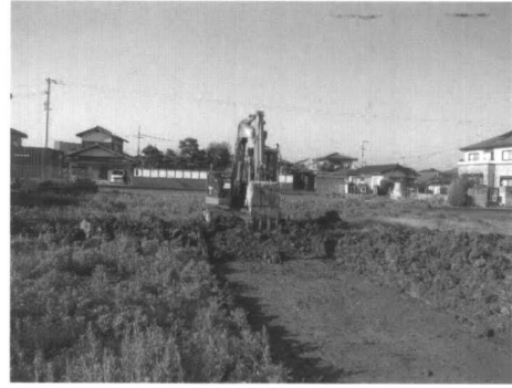
重機による掘削作業風景
