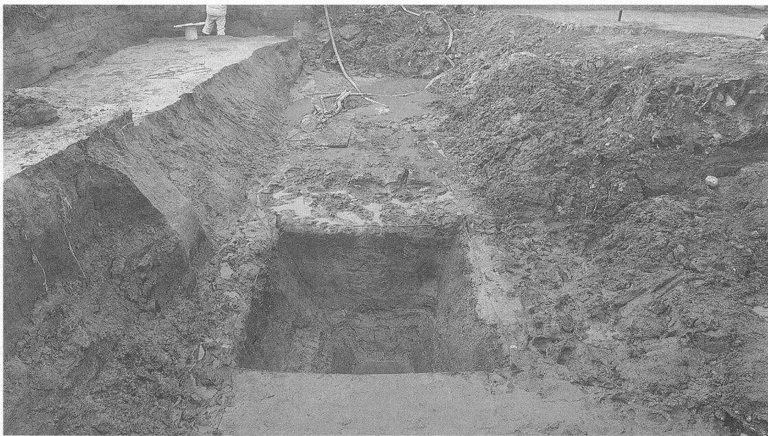
② 調査区南部の試掘坑
