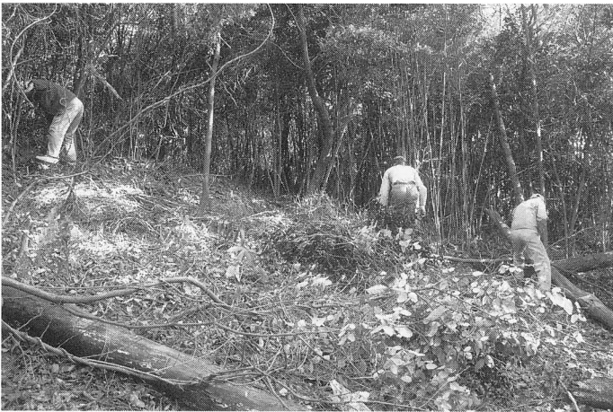
図版3 伐開作業風景
