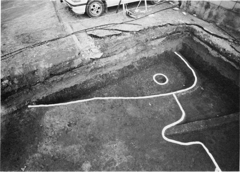
第126図 SH-29検出状況（北西から望む）
