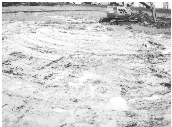
埋め戻し風景（北東から）
