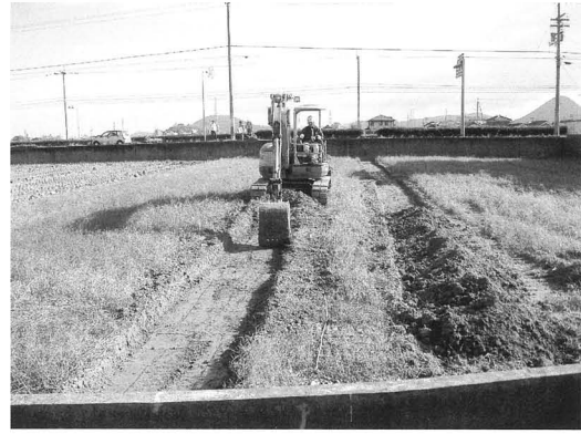
重機掘削風景（西から）
