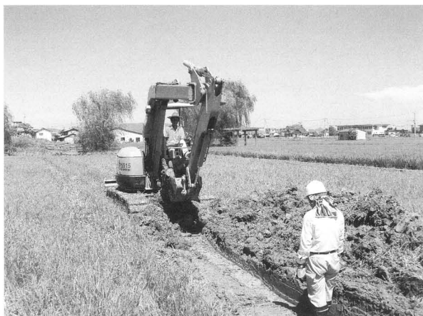
重機掘削風景（西から）
