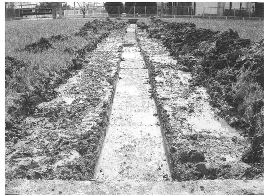
1トレンチ完掘状況（東から）
