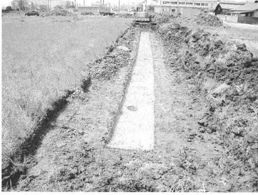
5トレンチ完掘状況（東から）
