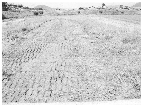
11トレンチ埋め戻し状況（西から）
