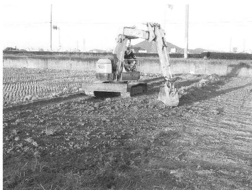
埋め戻し風景（西から）
