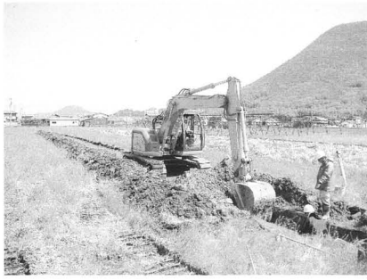
1トレンチ重機掘削風景（南から）
