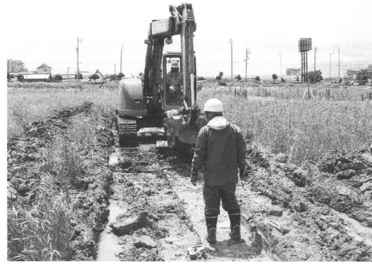
重機掘削風景（北から）
