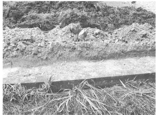
8トレンチSR01・SD02・SD03（南から）
