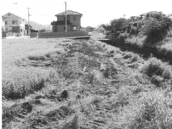
1~4トレンチ埋め戻し状況（東から）
