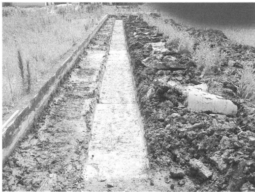
7トレンチ全景（東から）
