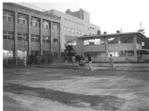
埋め戻し状況（北東から）
