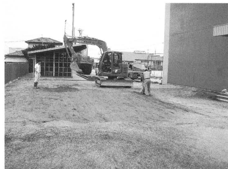
埋め戻し状況（北から）
