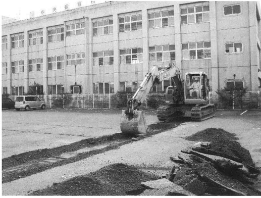
1トレンチ重機掘削風景（北から）
