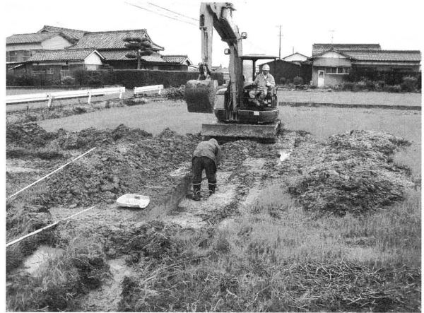
重機掘削風景（北から）
