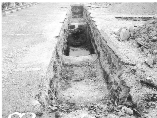
5トレンチ全景（東から）
