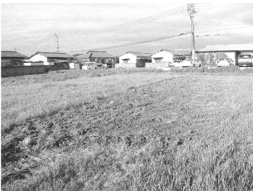
B地区埋め戻し状況（西から）
