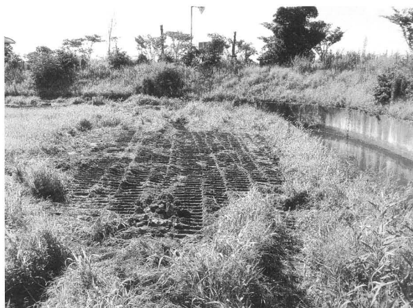
5トレンチ埋め戻し状況（南から）
