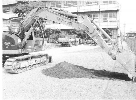
重機掘削風景（南から）
