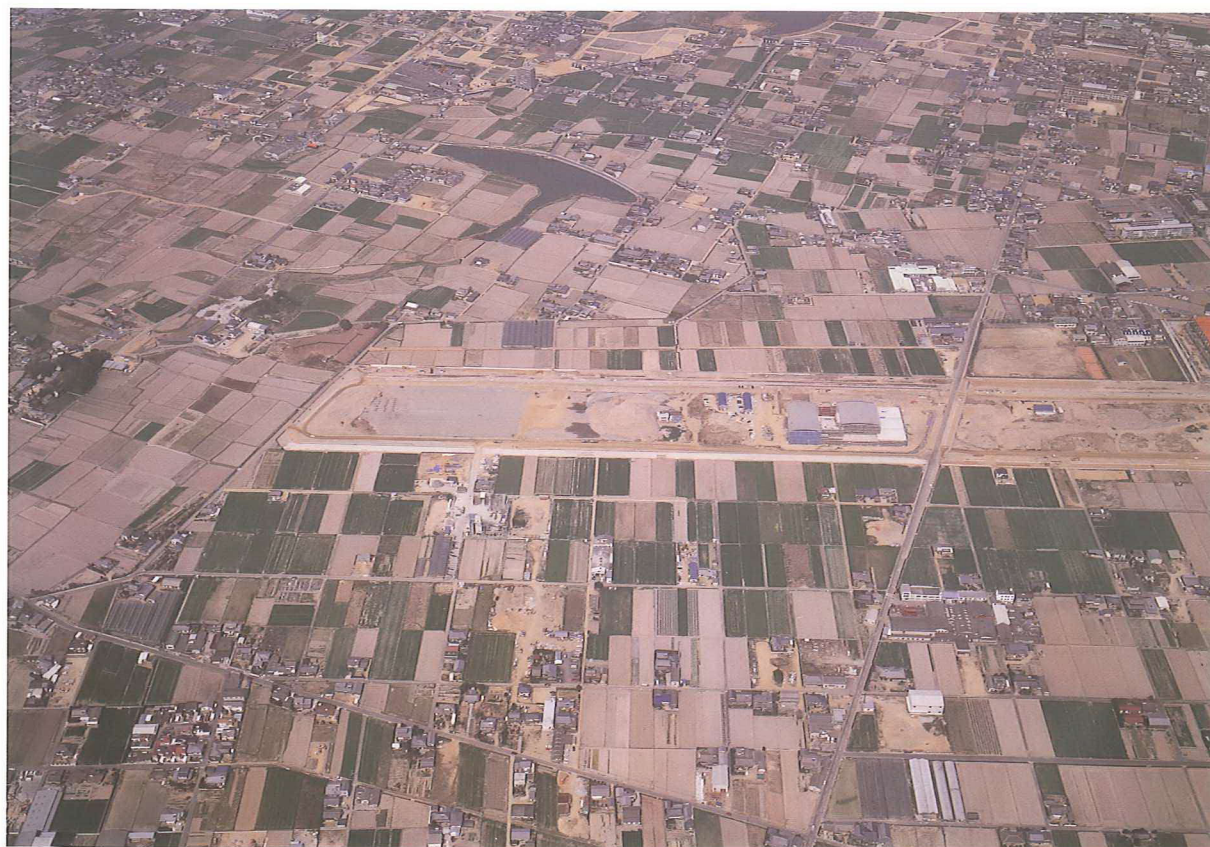
空港跡地遺跡 I 区全景 南から（建設中の建物が図書館、文書館）
