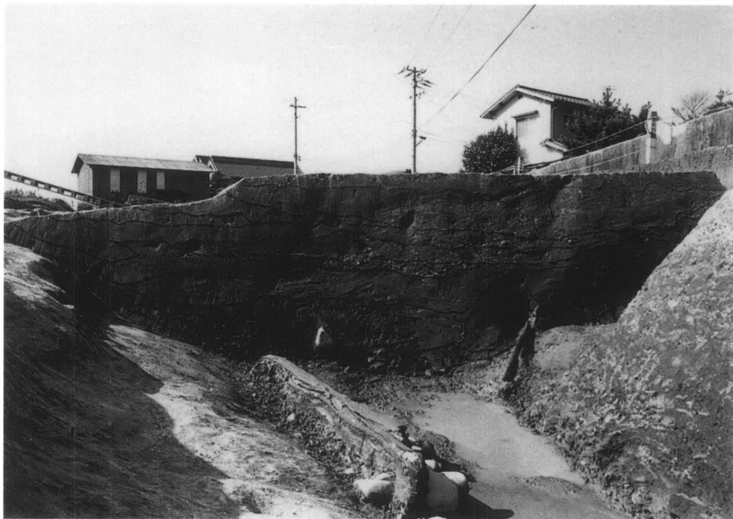
(1) IVB区 SR06 土層断面⑥ (南より)
