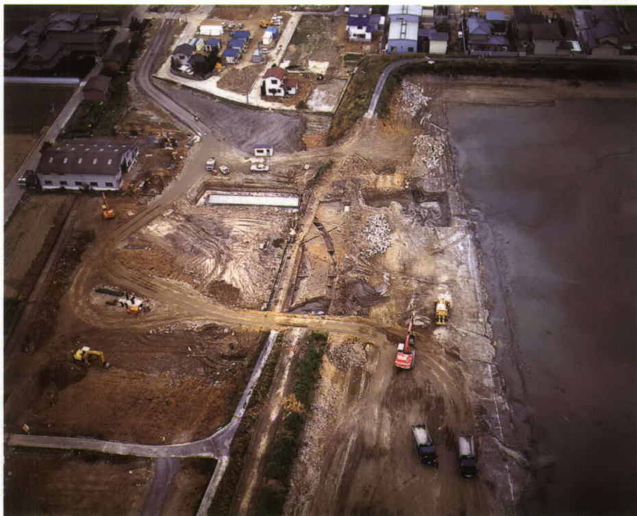
(1) 龍川五条遺跡前池地区空中写真（西より）
