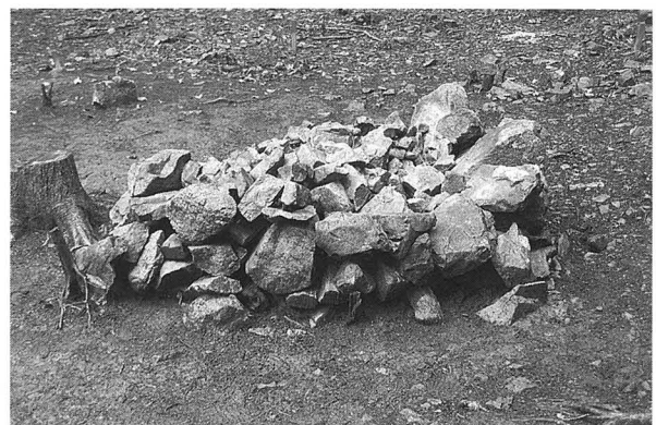
E) 落石除去後状況 (西より)
