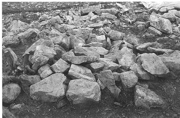
D) 落石除去後状況 (南西より)
