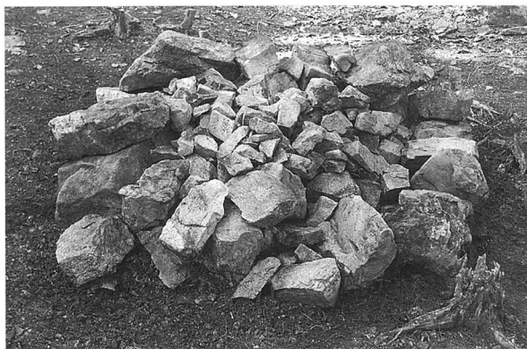
C) 落石除去後状況 (東より)
