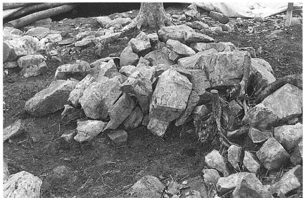
E) 落石除去後状況 (北西より)
