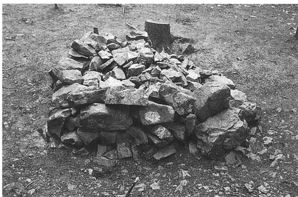
D) 落石除去後状況 (南より)
