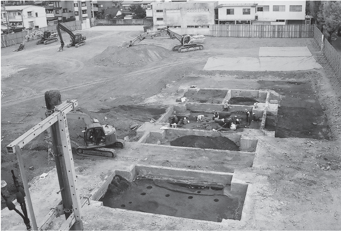
調査区遠景（南より）
