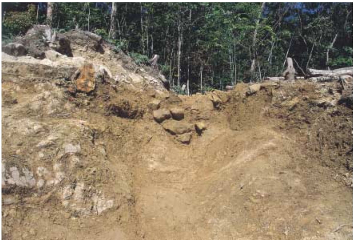
土橋1・2 南面状況
