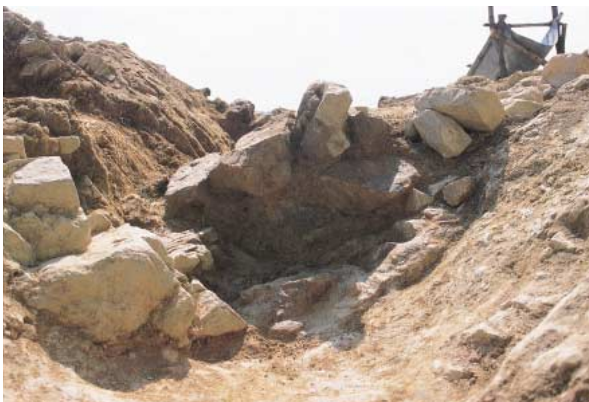
土橋2 北面状況
