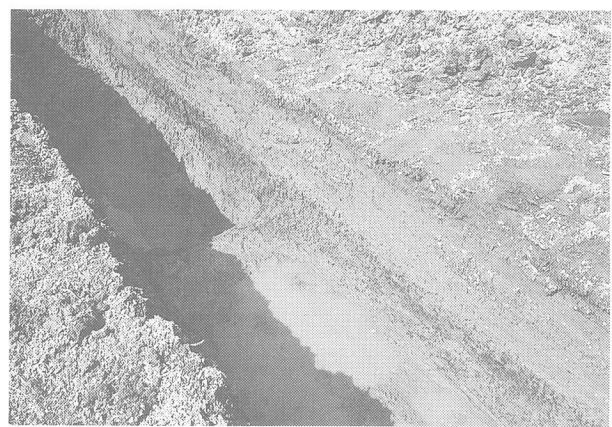
写真21 2 トレンチ土層
