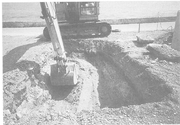
写真8 1トレンチ調査状況
