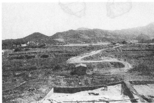
写真41 第3調査区全景
